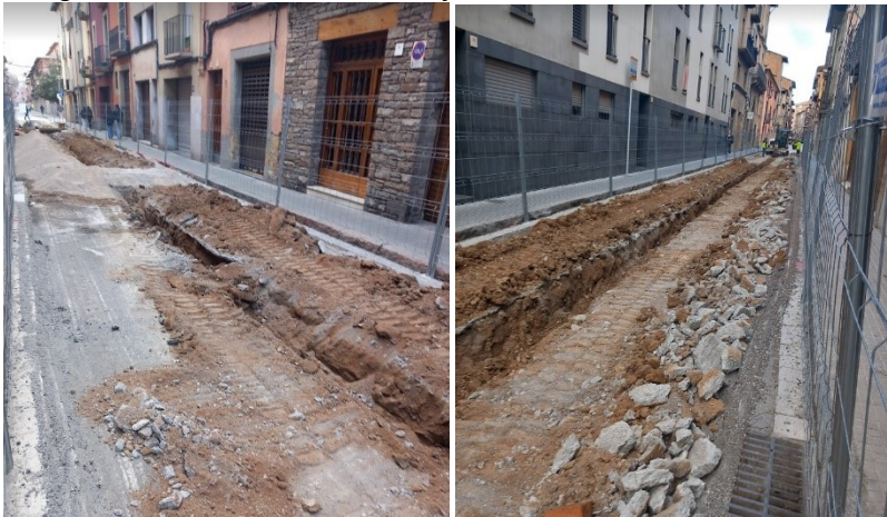
Imatge on s'indica la canalització de fibrociment a retirar.
