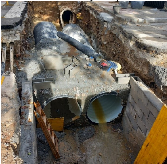
Imatge de la substitució del tub ovoide, de la prolongació del tub de clavegueram central i la cambra de connexió.
