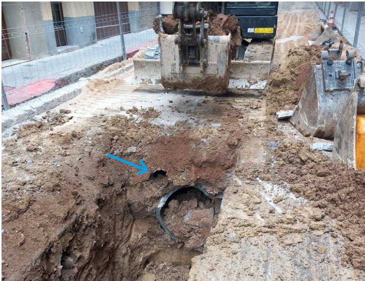
Imatge on s'indica la canalització de fibrociment a retirar.
