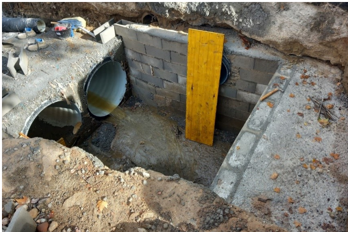
Imatge de la substitució del tub ovoide, de la prolongació del tub de clavegueram central i la cambra de connexió.
